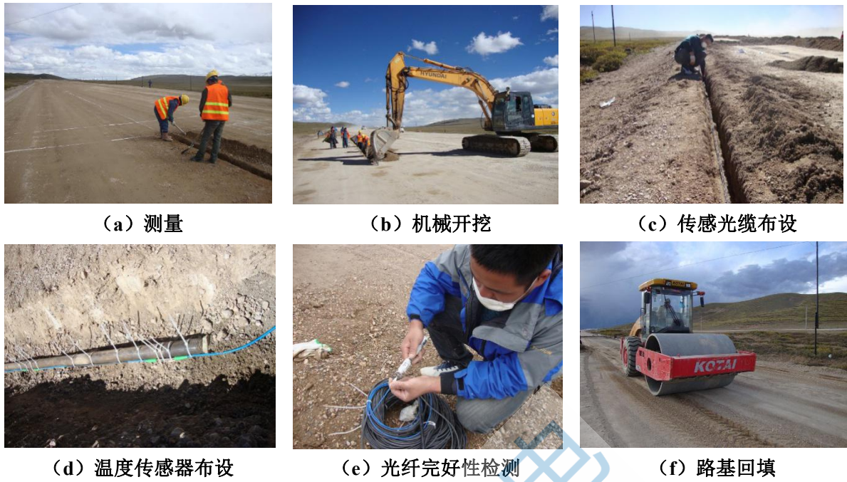
图 3 分布式光纤传感系统布设工艺
